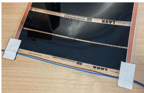
Svrchní izolace konektorů
